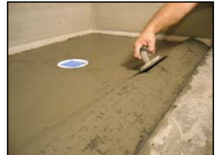
Rellénelo con la mezcla
