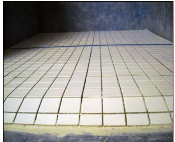
Instalación en base delgada.
